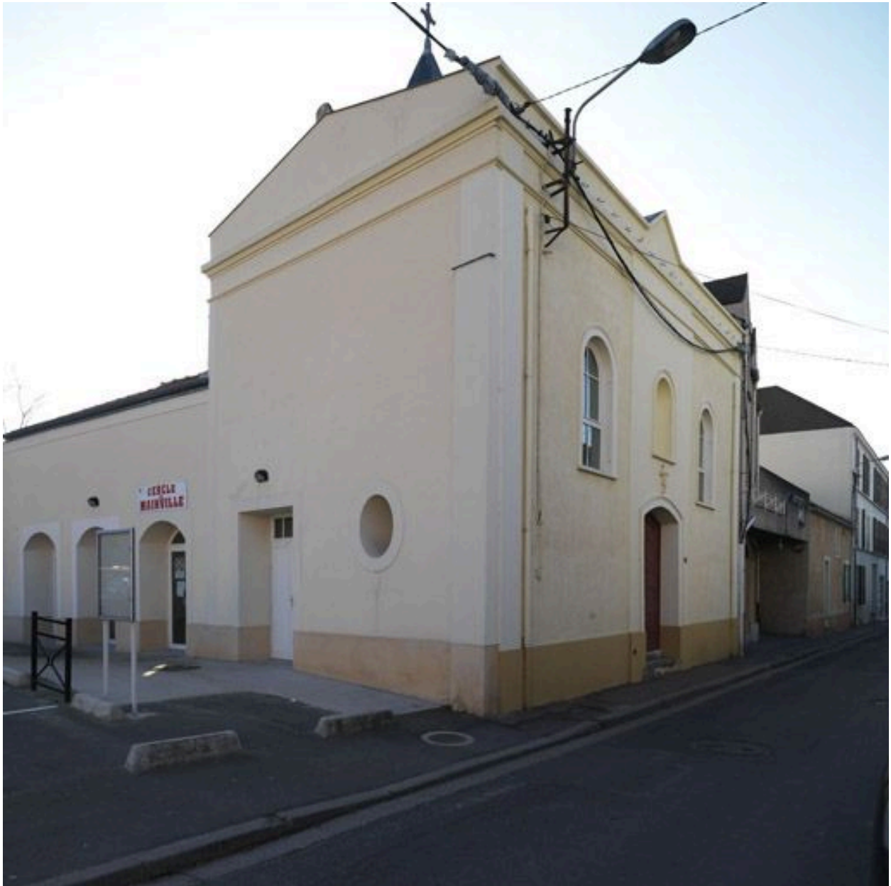
Vue des façades principale et latérale est.
