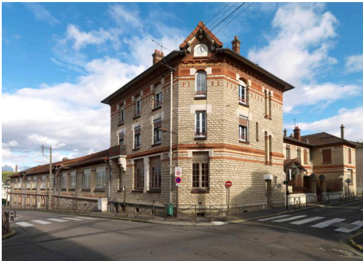
Vue de la façade à l'angle des rues Castor et des Écoles.
