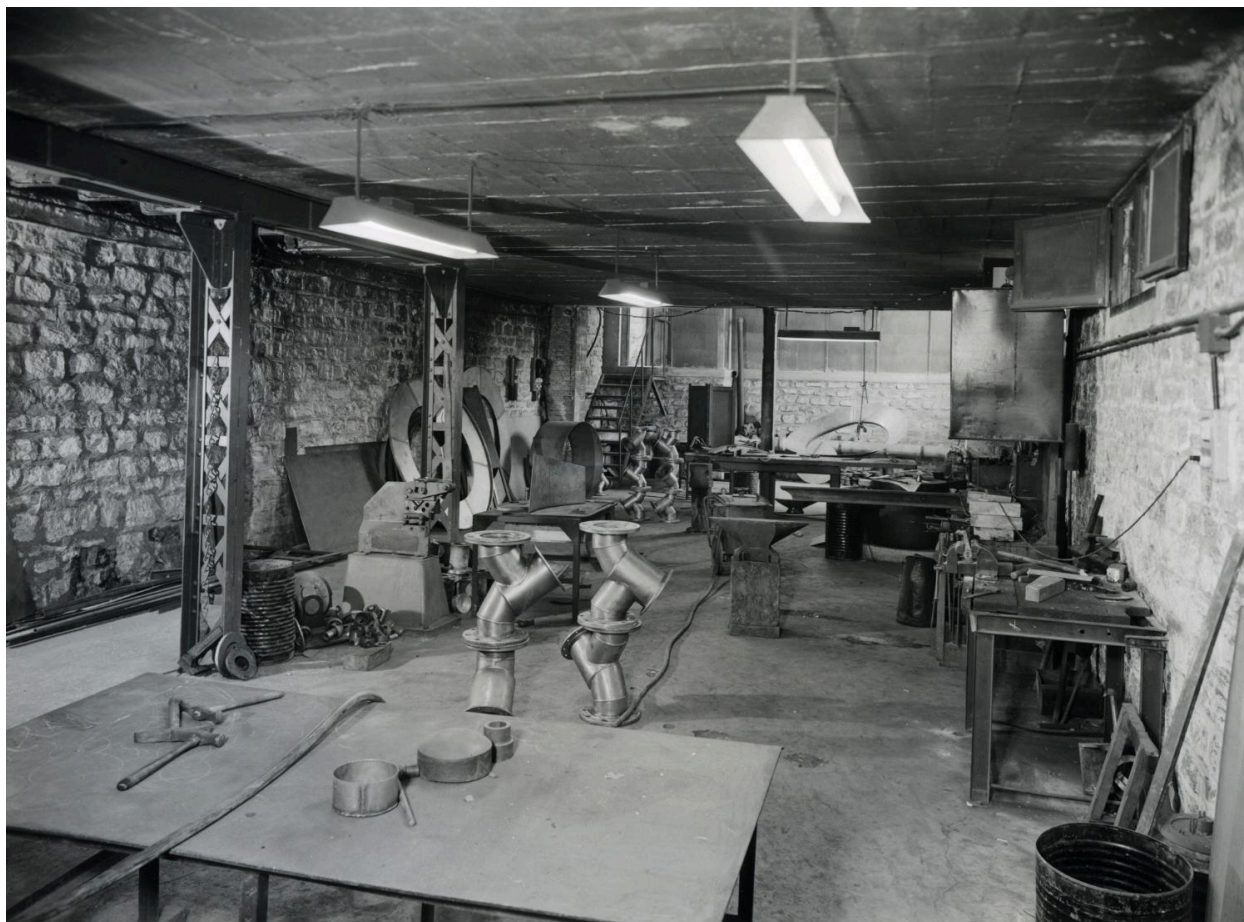
Atelier de chaudronnerie métallique, au sous-sol. Tirage photographique noir et blanc, 18 x 24 cm, années 1950, Studio Louisianne, 152 avenue Danielle Casanova, Ivry-sur-Seine (collection Ateliers de Technochimie).
