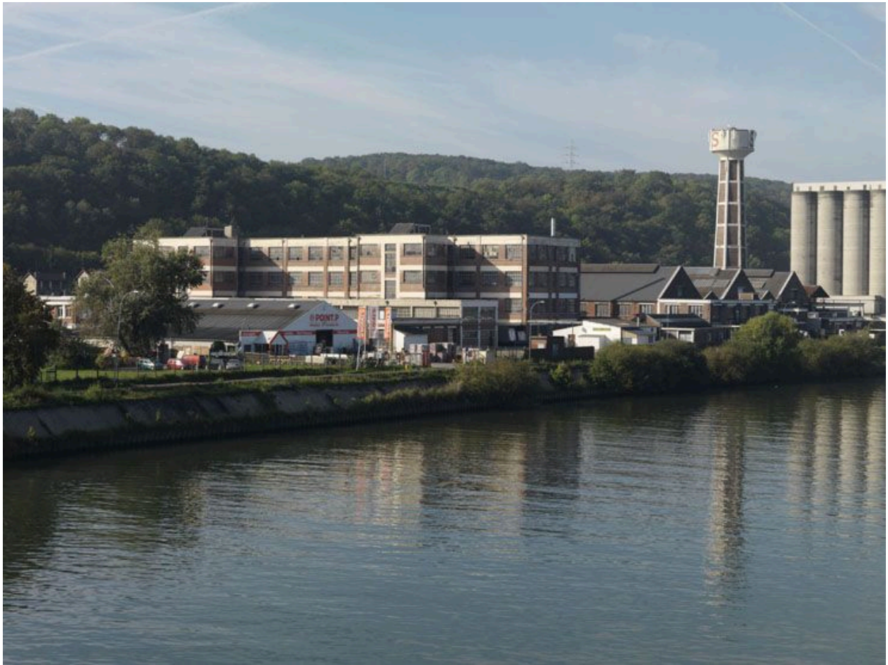
Bonnières-sur-Seine : vue depuis le pont vers l'aval. Anciennes usines Singer et leur château d'eau.
