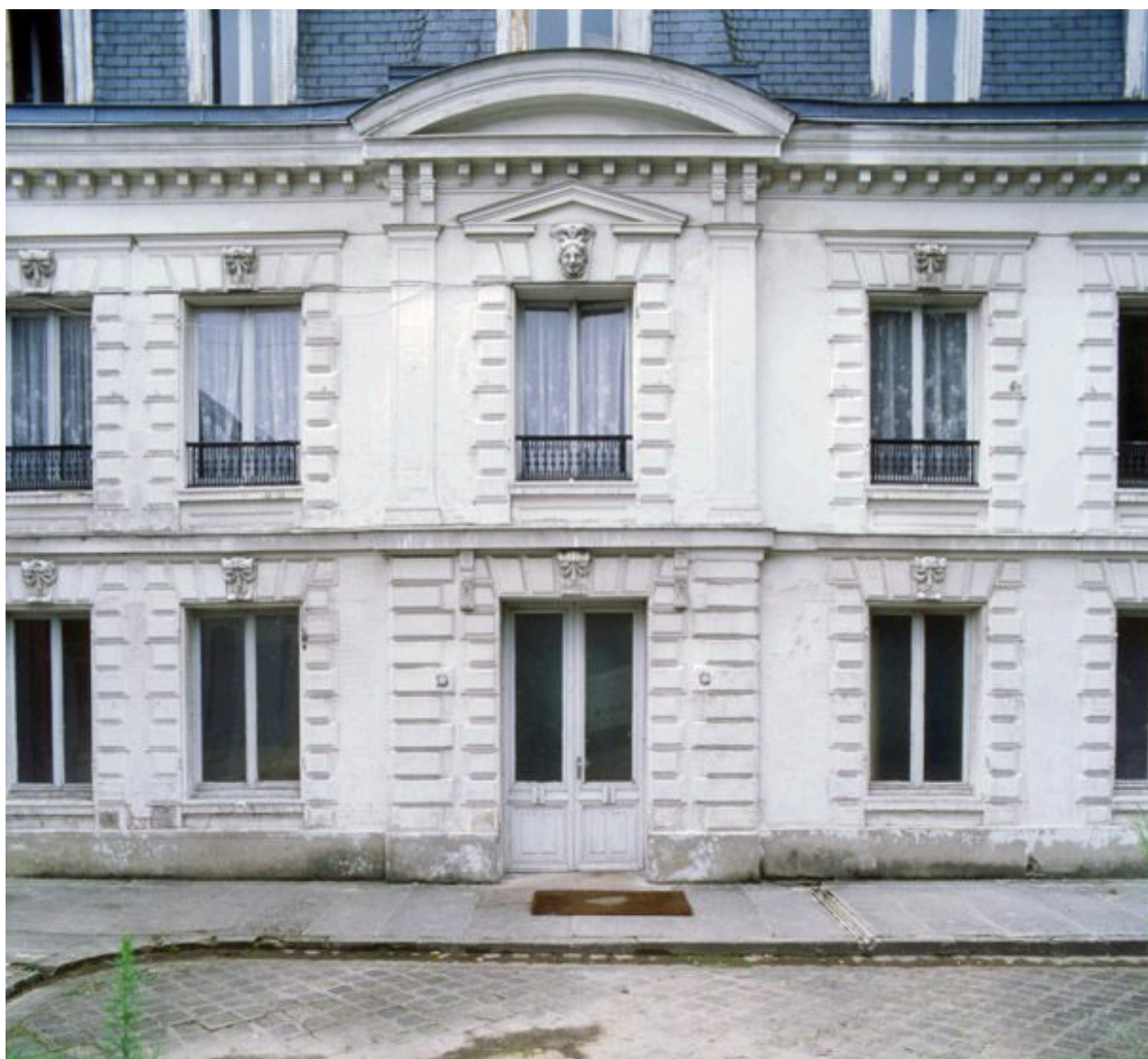
Détail de la façade principale.
