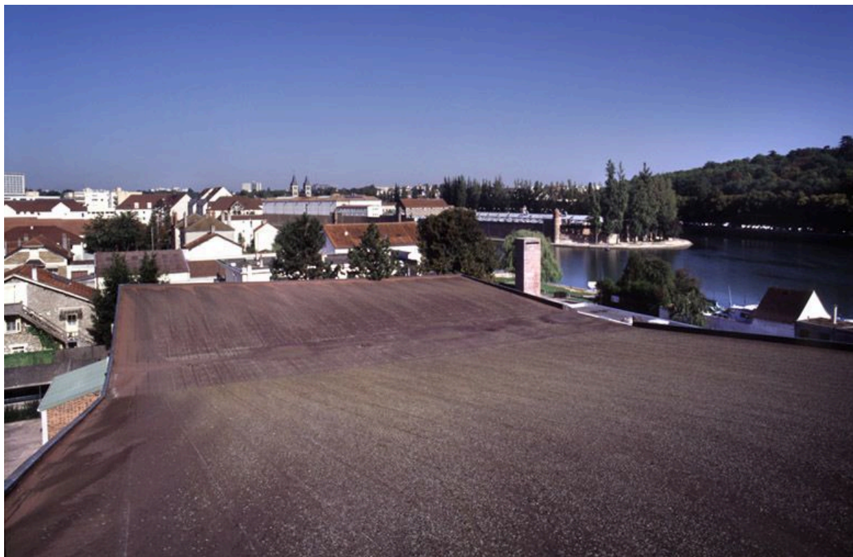
La piscine couverte : vue du toit-terrasse des bassins, avec panorama sur la ville et l'île Saint-Etienne.
