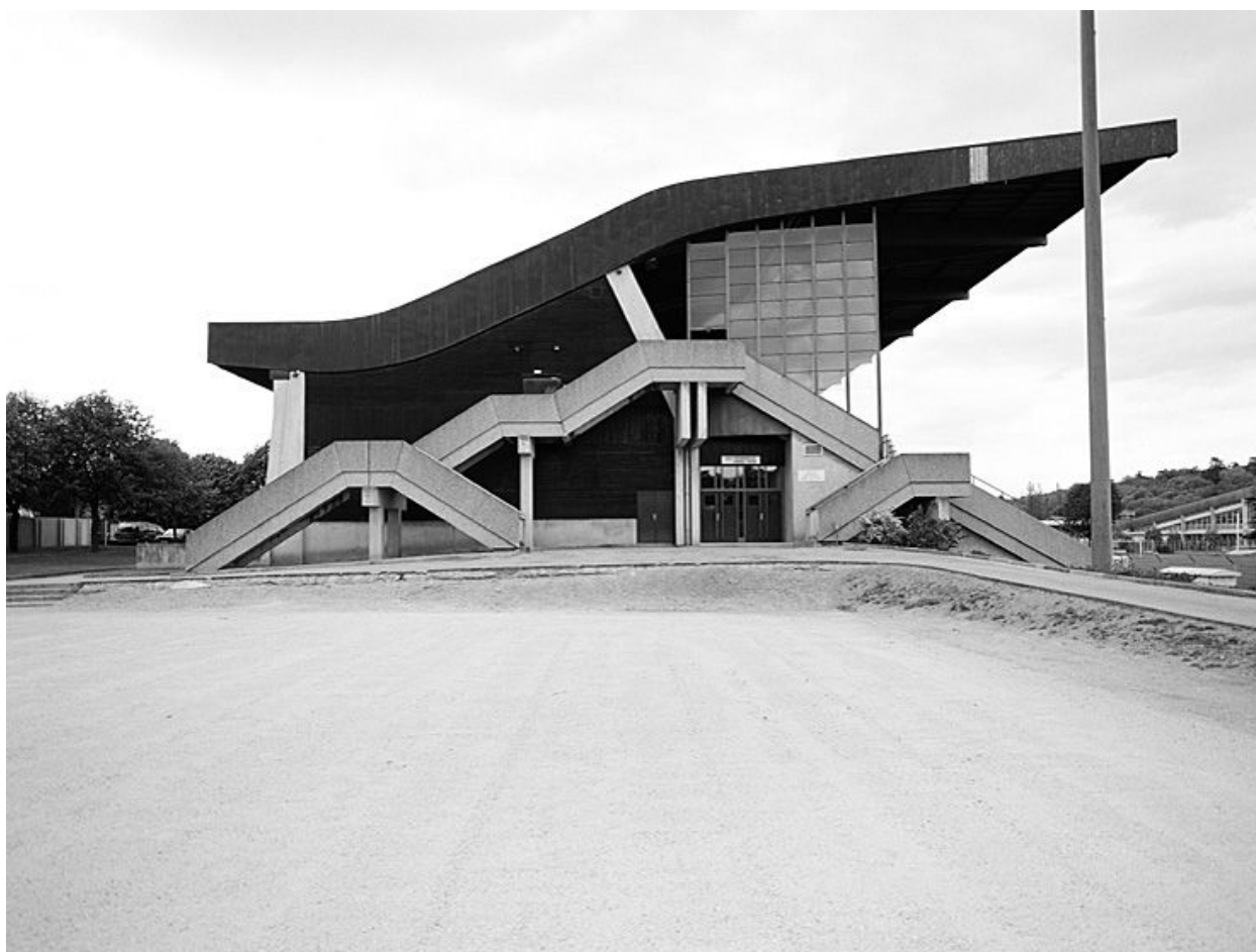
Le bâtiment des tribunes : mur pignon sud.
