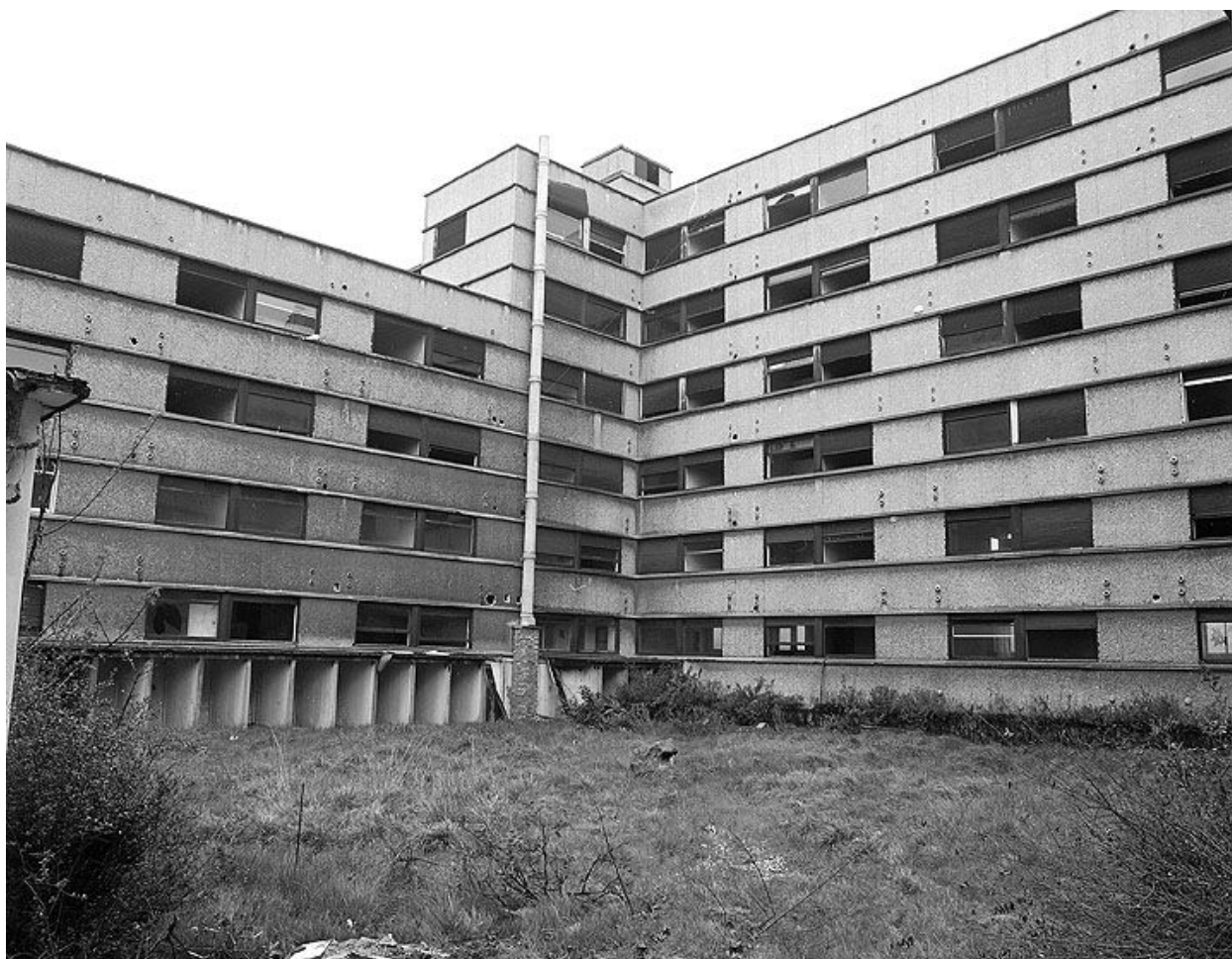
Bâtiment A - Cour est, coin nord ouest. Campagne photographique, lors de la destruction du bâtiment en 1976.
