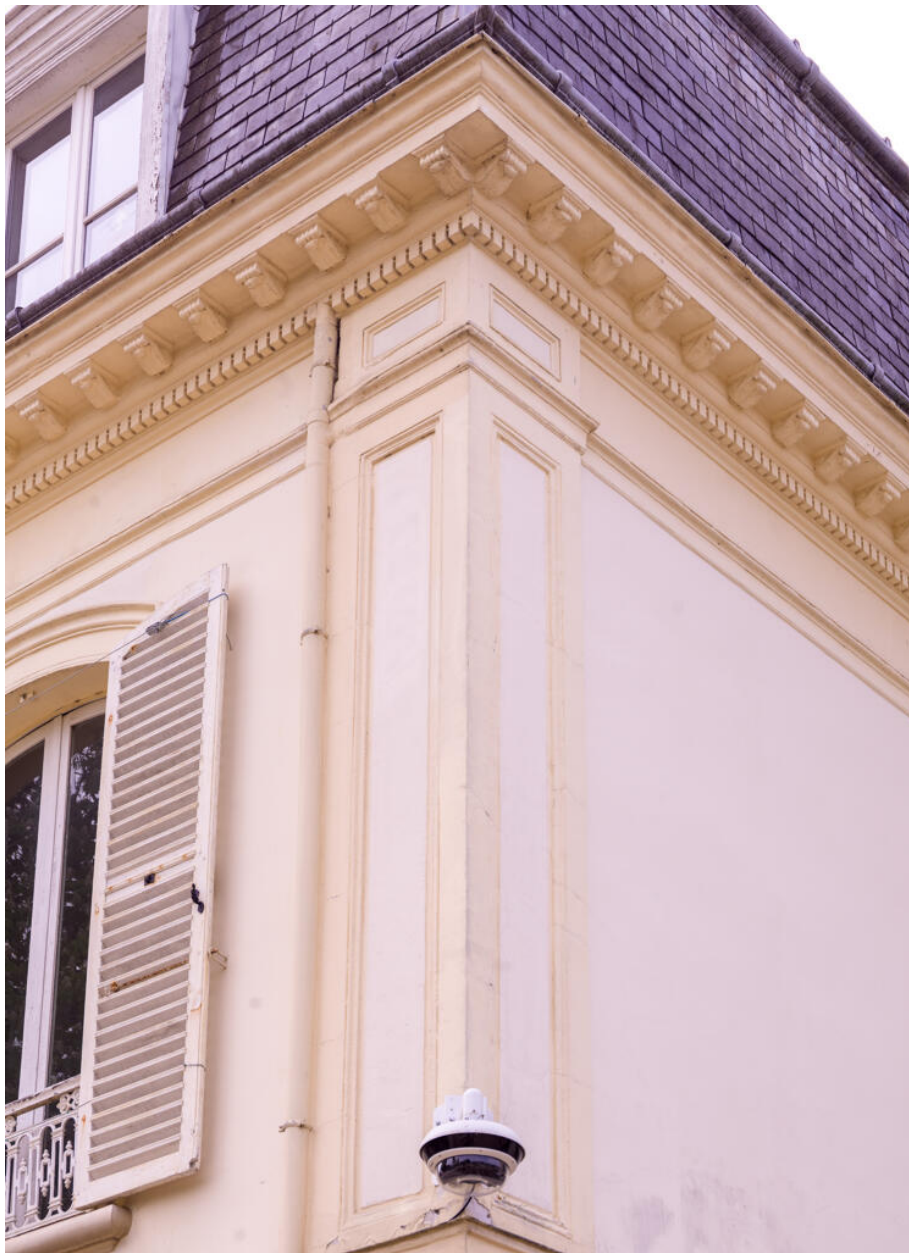
Vue du décor aux angles des façades.
