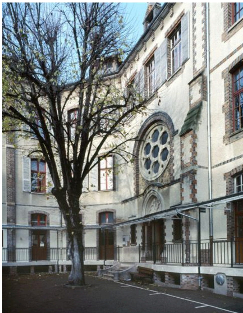
Le bâtiment principal : élévation sud, avec l'entrée de la chapelle.
