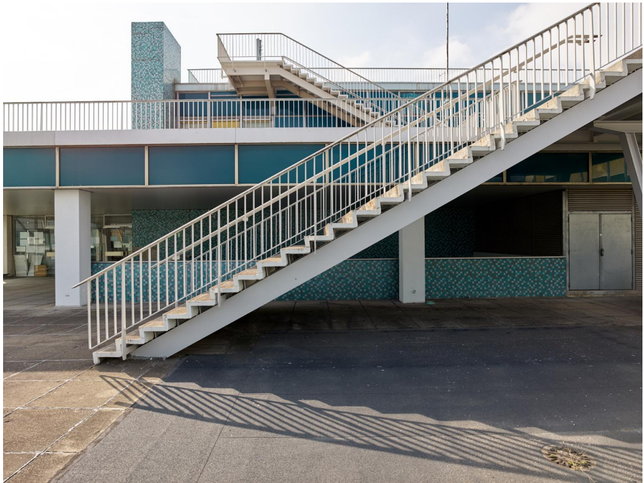
2018, terrasses, circulation verticale: escaliers est, 4ème étage.
