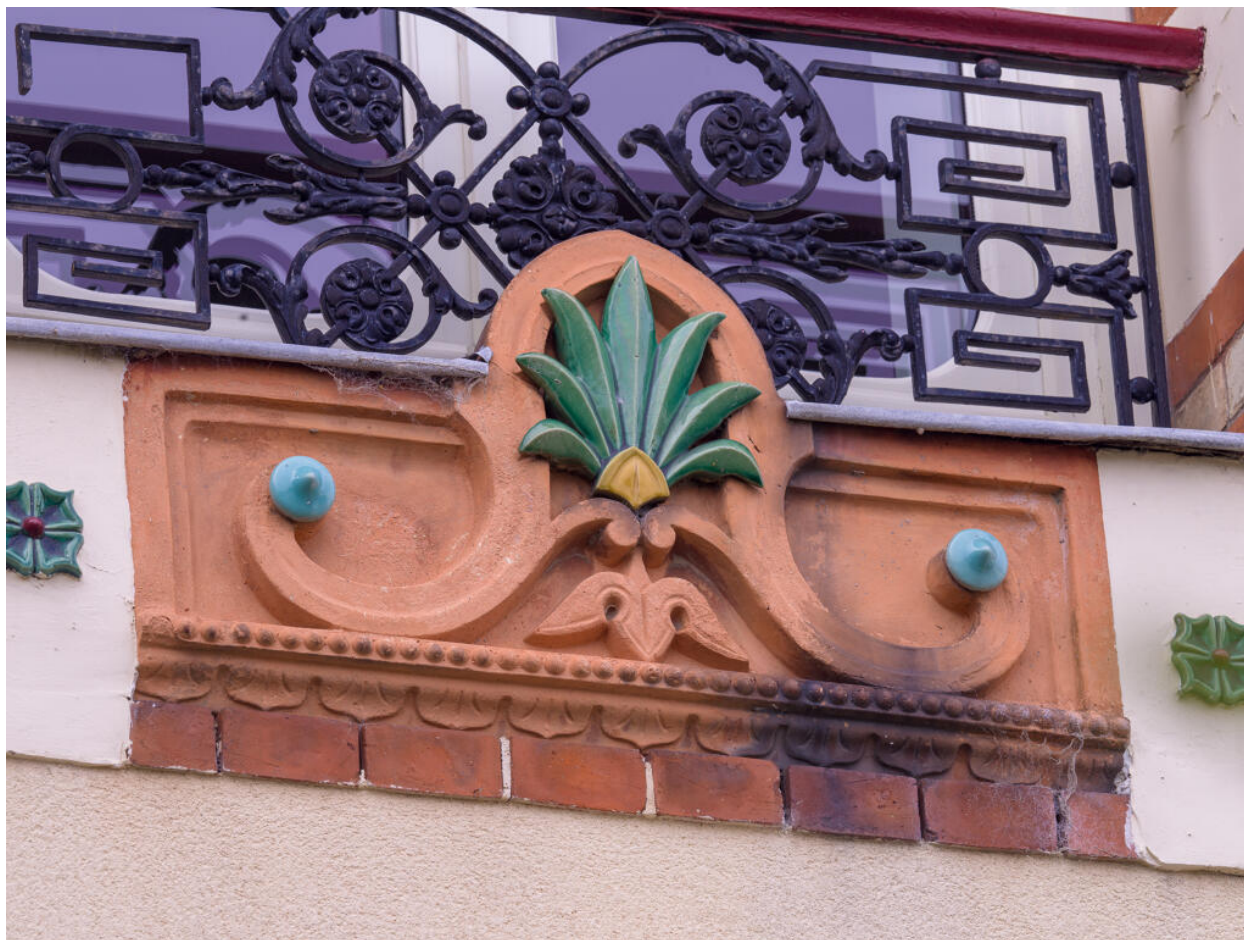
Vue de la façade nord, détail d'un décor de palmette en céramique.
