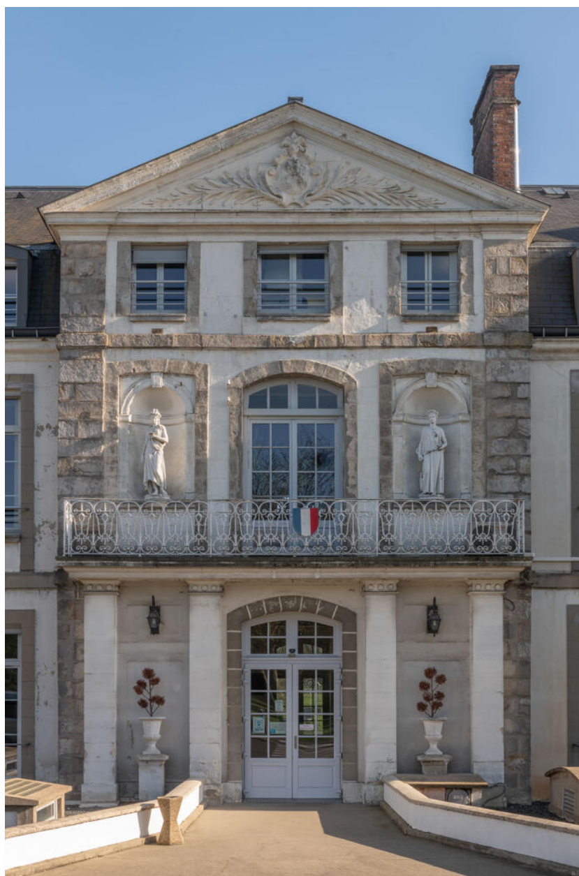
Façade ouest, le corps central.
