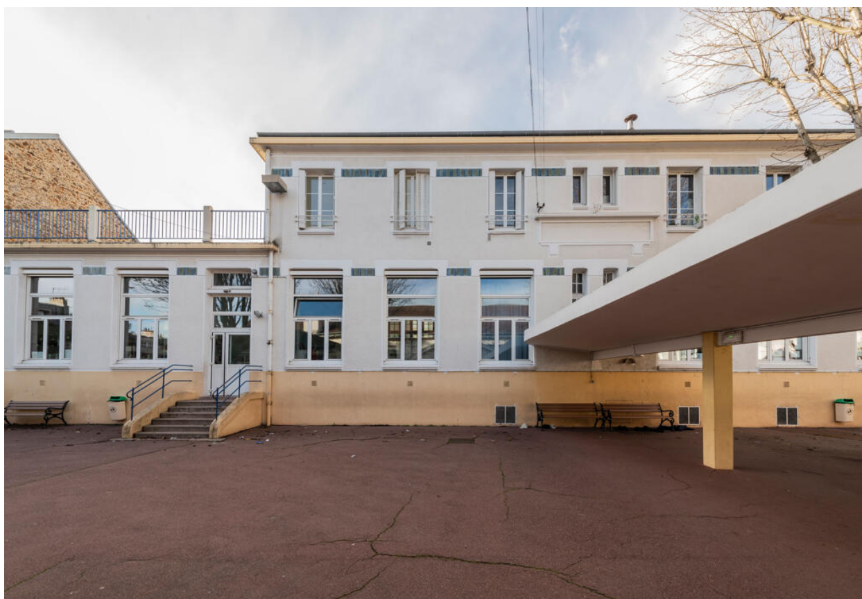
École des Coteaux, bâtiment de 1922, façade orientale sur cour
