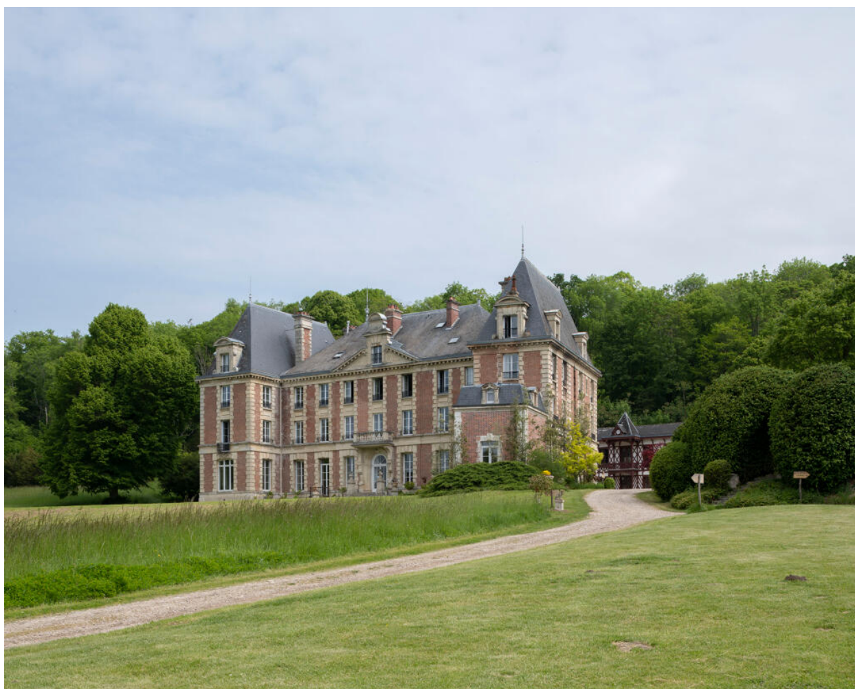
La façade sud-ouest sur jardin. A l'arrière plan, le bâtiment de la bibliothèque.
