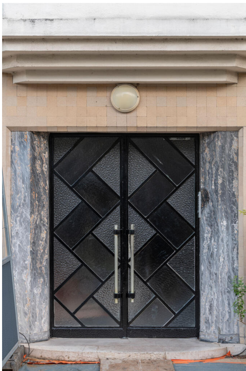
Immeuble, porte d'entrée en verre martelé
