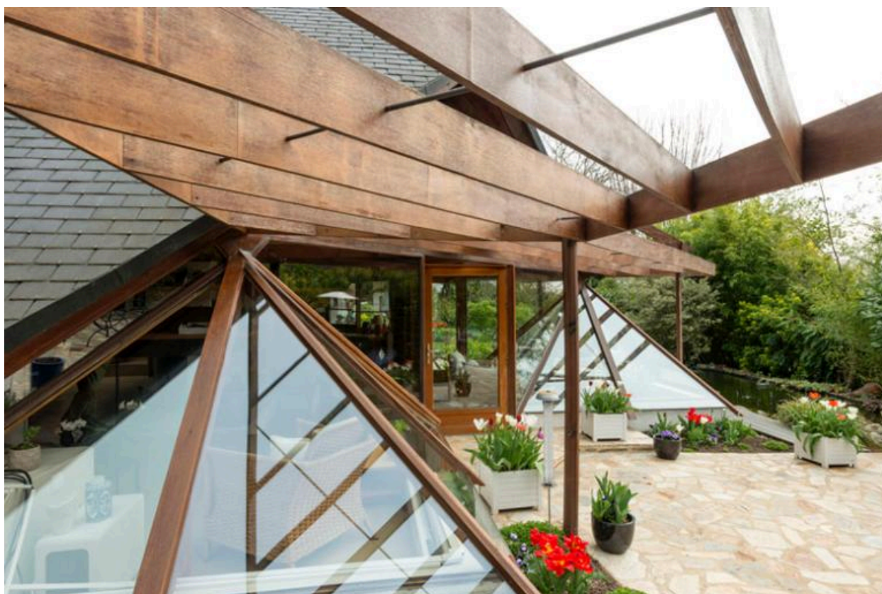
Vue latérale de la façade latérale gauche : détail des deux vérandas pyramidales.
