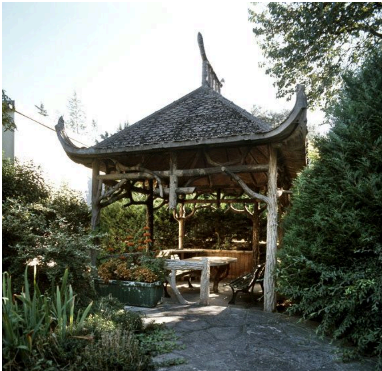
Fabrique de jardin en forme de pagode chinoise construite en béton imitant le bois, 95 rue des Héros Nogentais.
