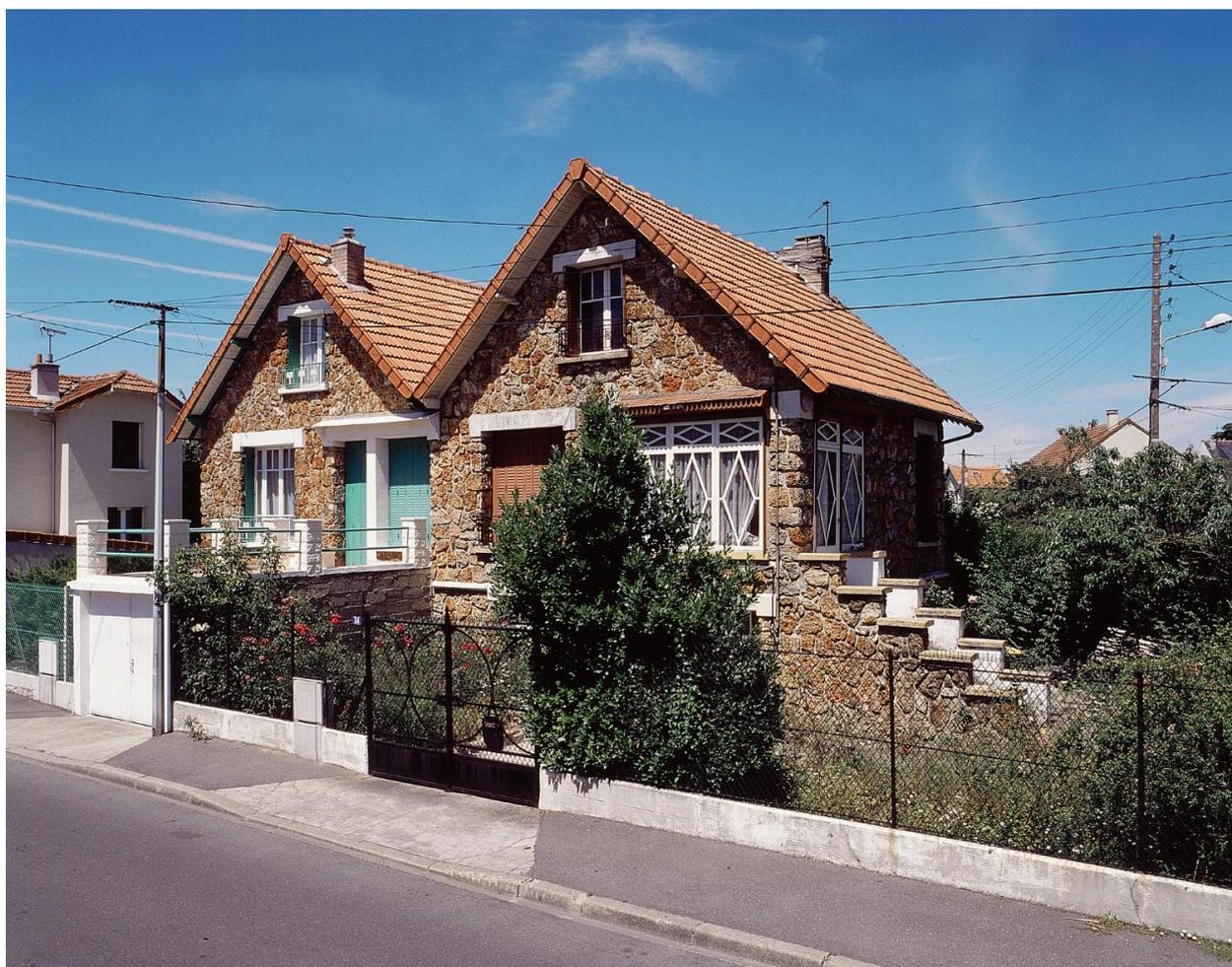
Vue d'ensemble : un escalier dont le mur d'échiffre est placé dans le prolongement de la façade donne accès au rez-de-chaussée fortement surélevé.
