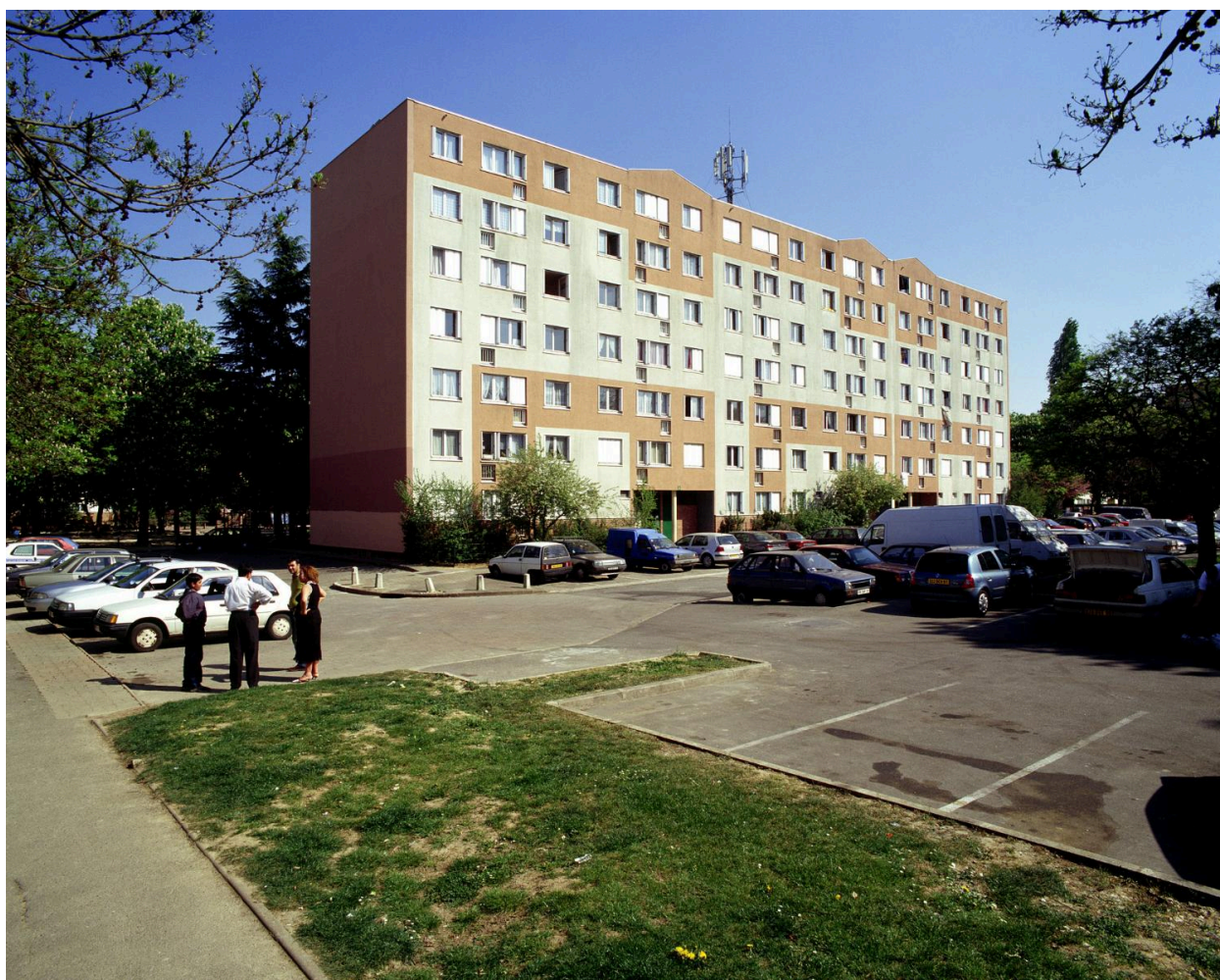
Vue d'ensemble de l'immeuble de six étages (immeuble U du programme 1962-1964) situé à l'arrière de l'église et du Centre Michelet.
