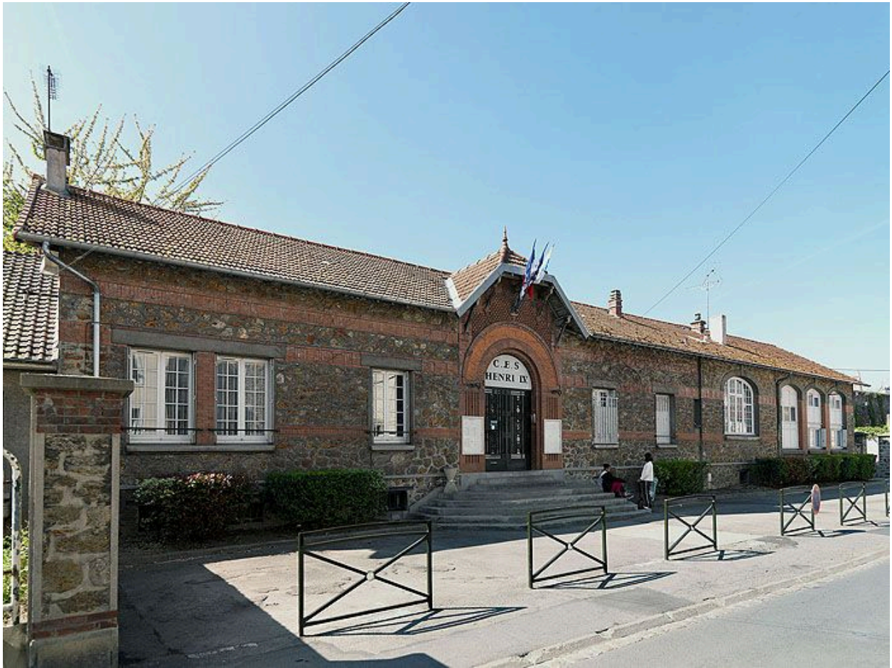
La façade du collège Henri IV, sur la rue Fatou : vue d'ensemble, depuis le nord-est.
