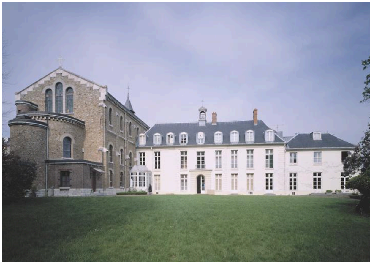
Façade sur le parc.
