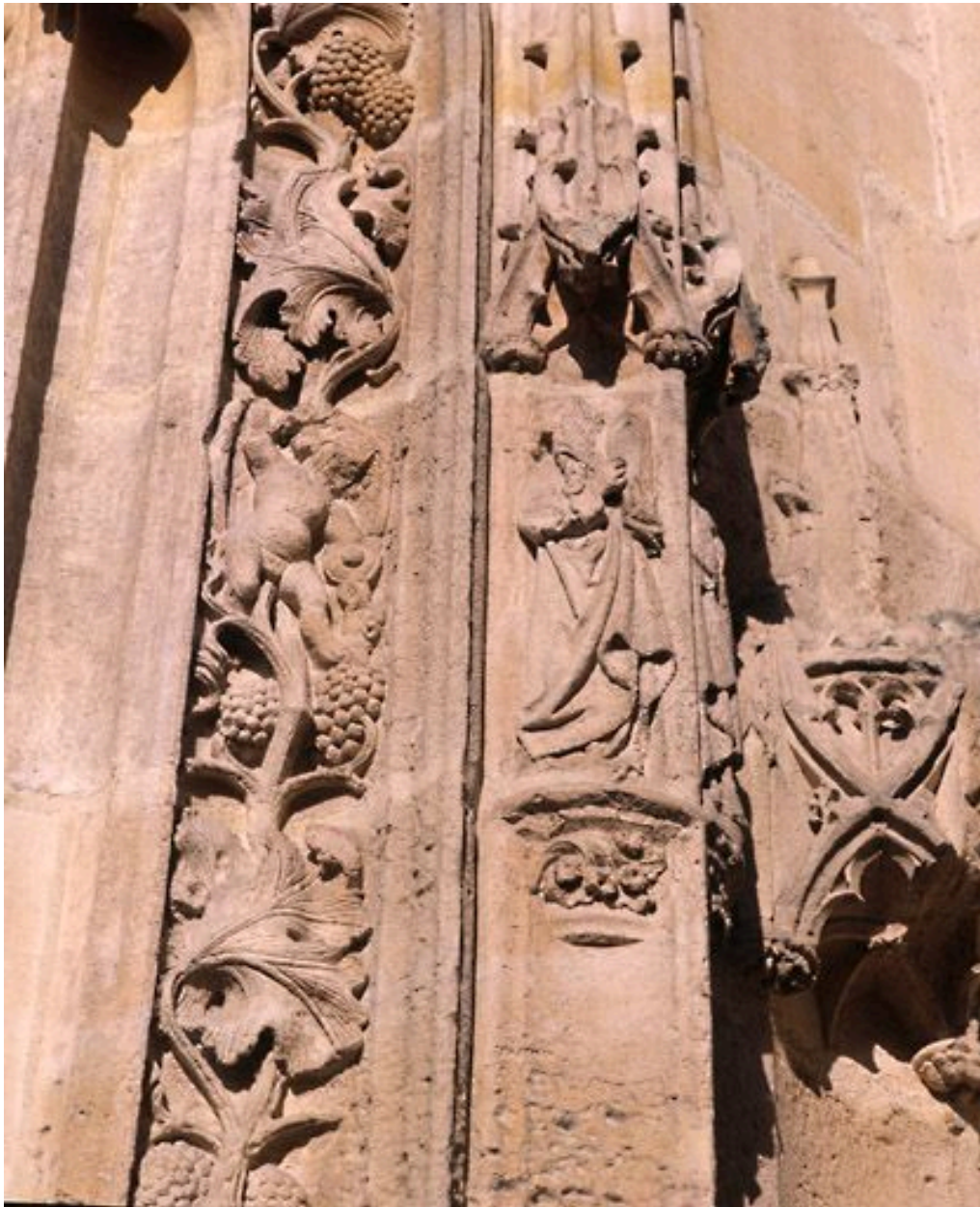
Détail : sculptures du portail méridional de la façade est (sur la rue Saint-Aspais).
