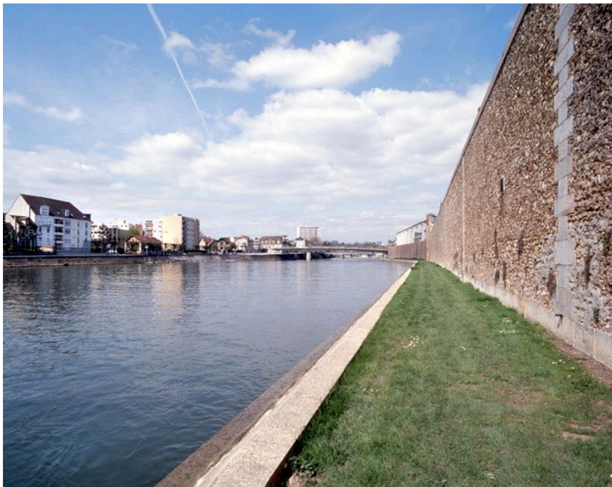
Le mur d'enceinte de la maison centrale, côté sud, et le quai de l'île Saint-Etienne le long du grand bras de la Seine.
