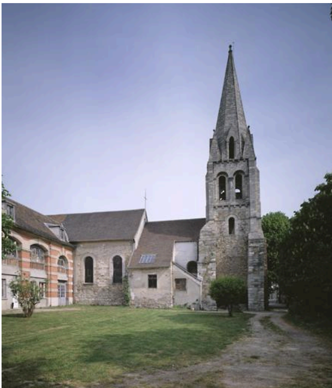
Vue d'ensemble du côté sud de l'église donnant sur la cour des communs du château, ancien jardin du prieuré d'Athis.
