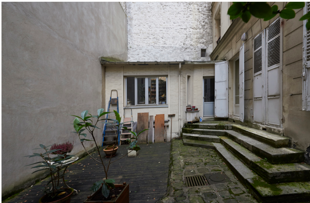
Vue de la courette du côté droit. On aperçoit le mur du 17 rue Ernest-Cresson.
