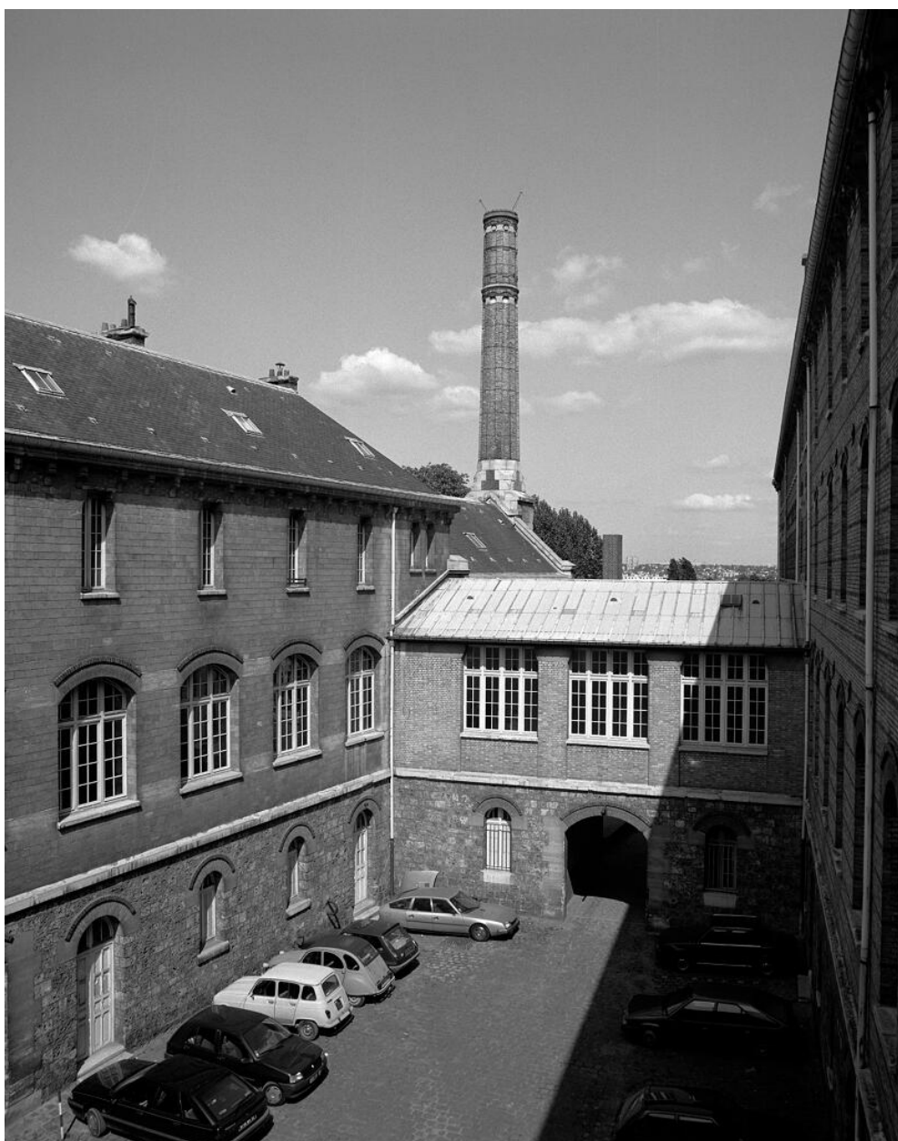
Cour des cuisines : vue d'ensemble. On remarquera l'imposante cheminée d'origine. Lycée dit Lycée Lakanal
