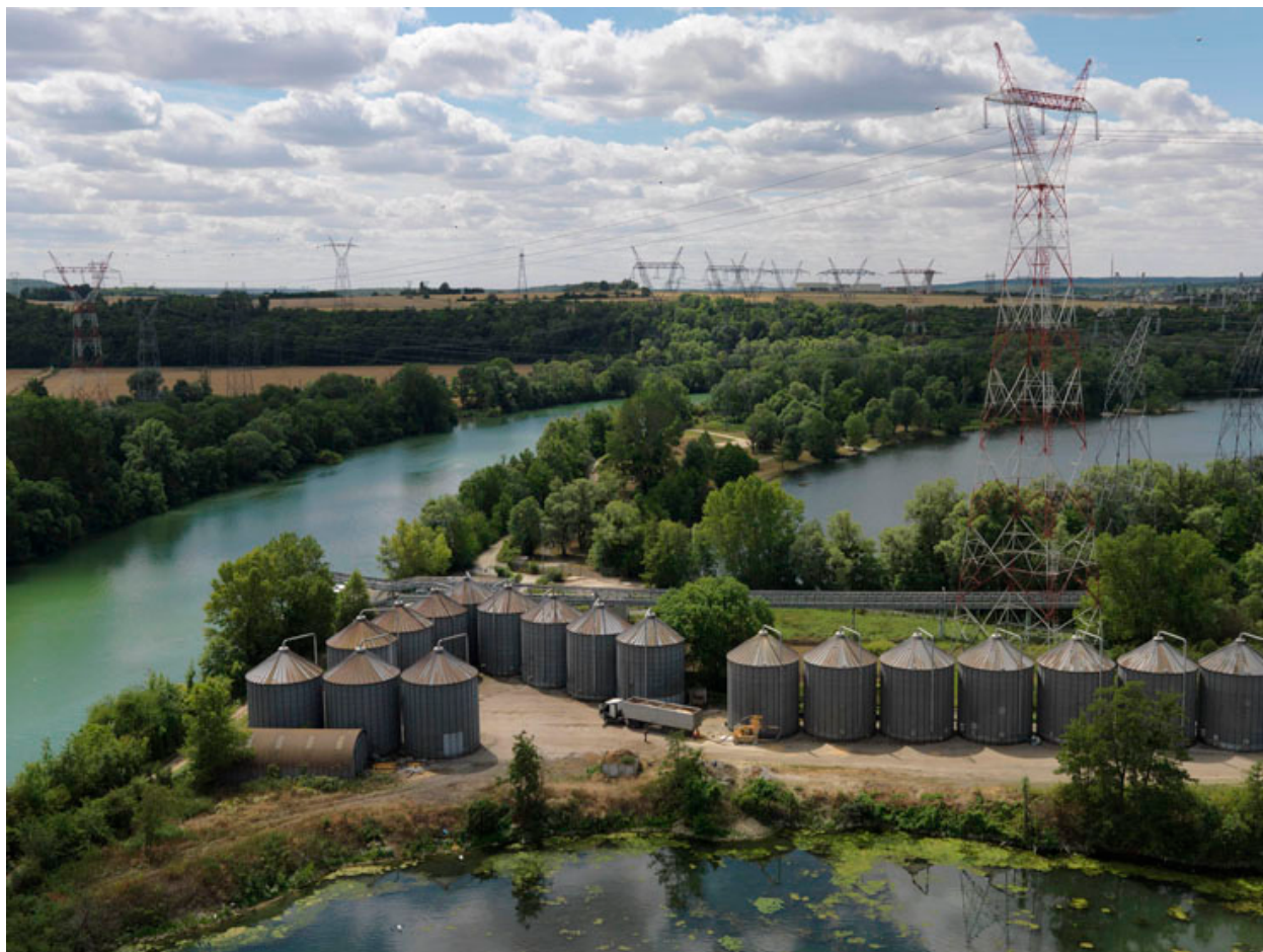
Silos de l'UNCAC Invivo de la Grande Paroisse. Silos 7 vus depuis la tour de travail du silo 6.
