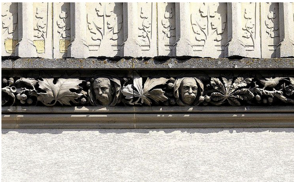
Le pignon ouest de la chapelle : détail de la frise (partie gauche).
