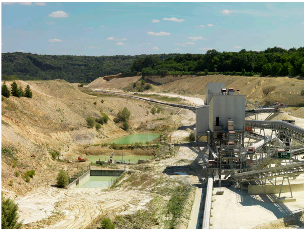
Plateforme - installation secondaire.
