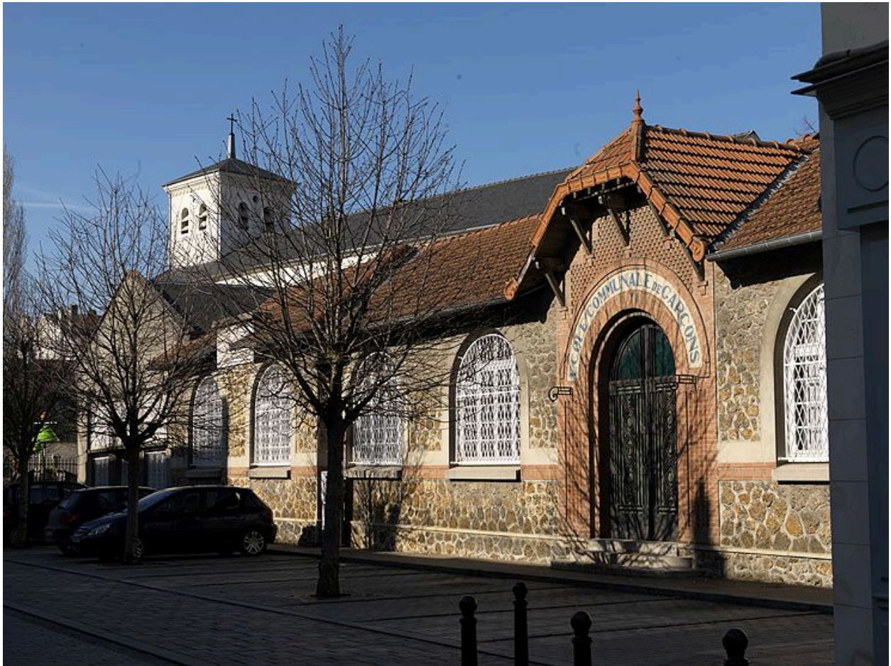
La façade de l'école primaire Pasteur, rue du Faubourg-Saint-Nicolas.
