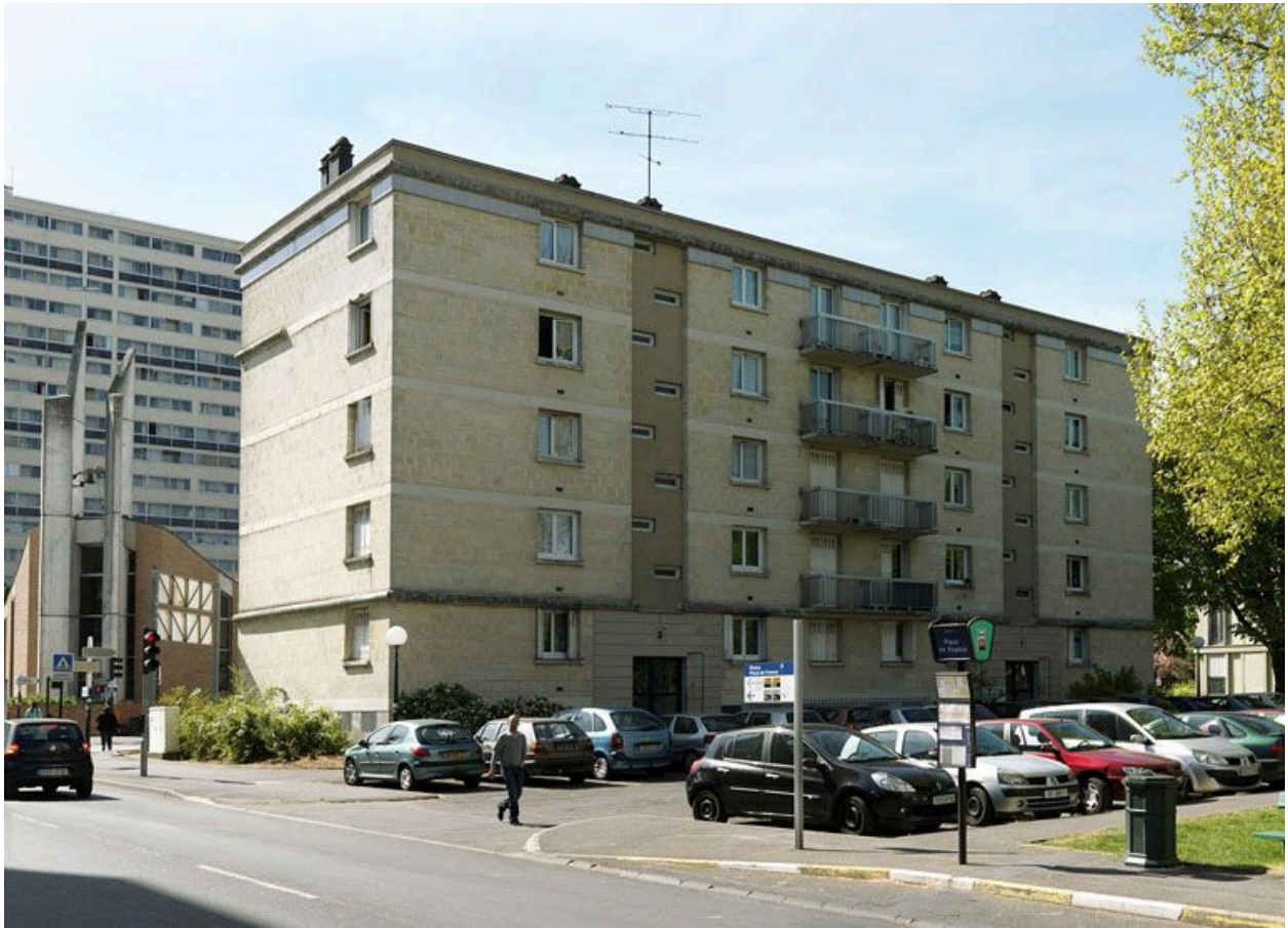
Façade principale sur parking de la barre B.
