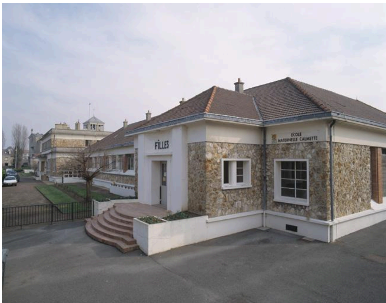
Vue de l'aile sud-ouest du bâtiment.
