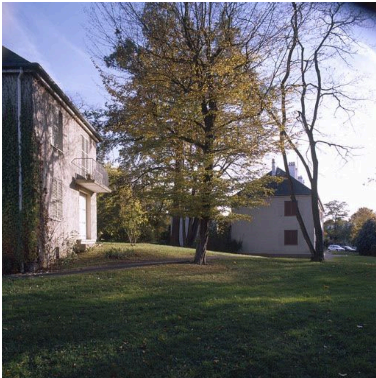
Façade antérieure et pignon de deux pavillons semi-individuels.
