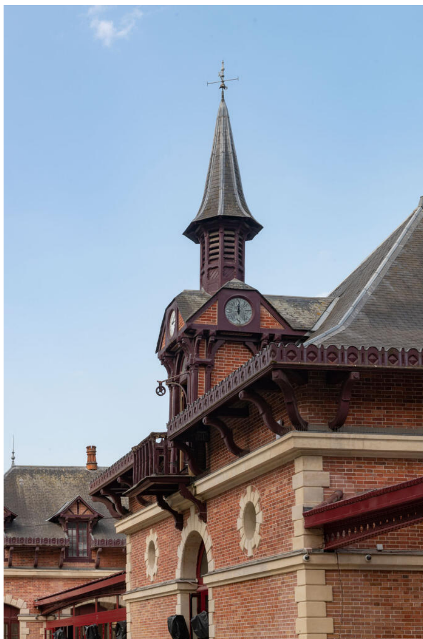
Lanternon sur le bâtiment des anciennes écuries
