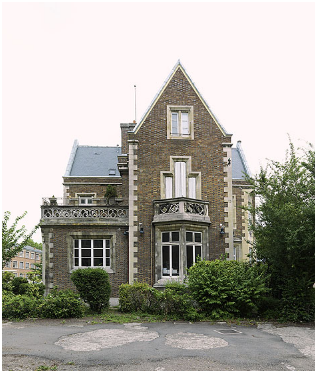
Détail de l'une des façades latérales.
