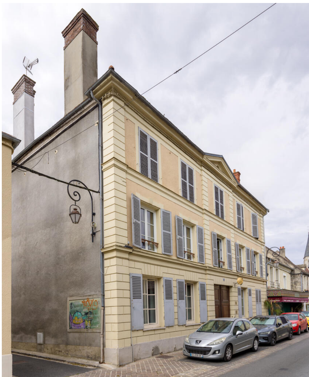
Vue générale depuis l'angle nord-est.
