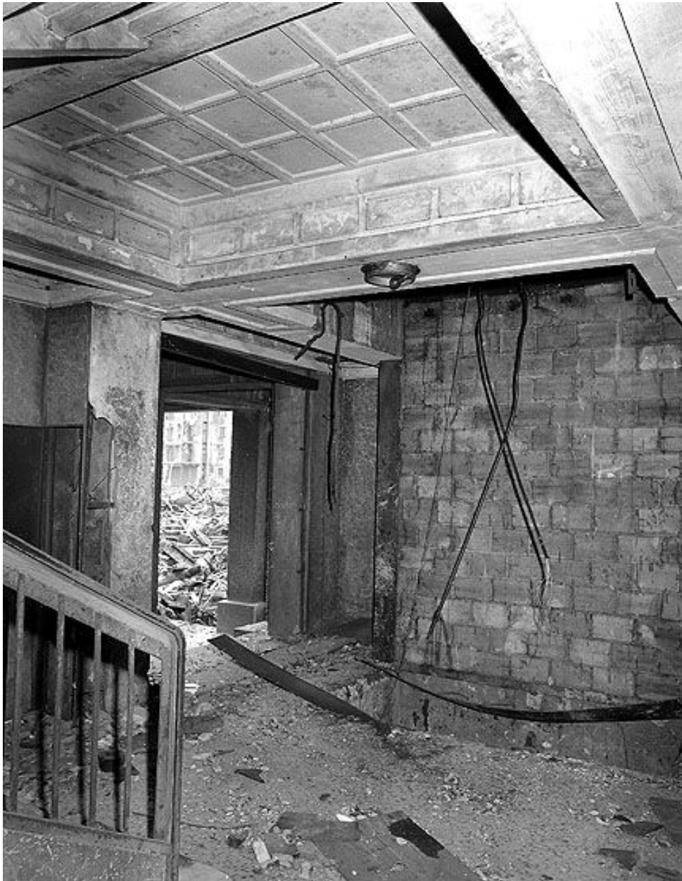
Tour 1, Départ de la cage d'escalier, au fond cage d'ascenseur. Campagne photographique, lors de la destruction du bâtiment en 1976.
