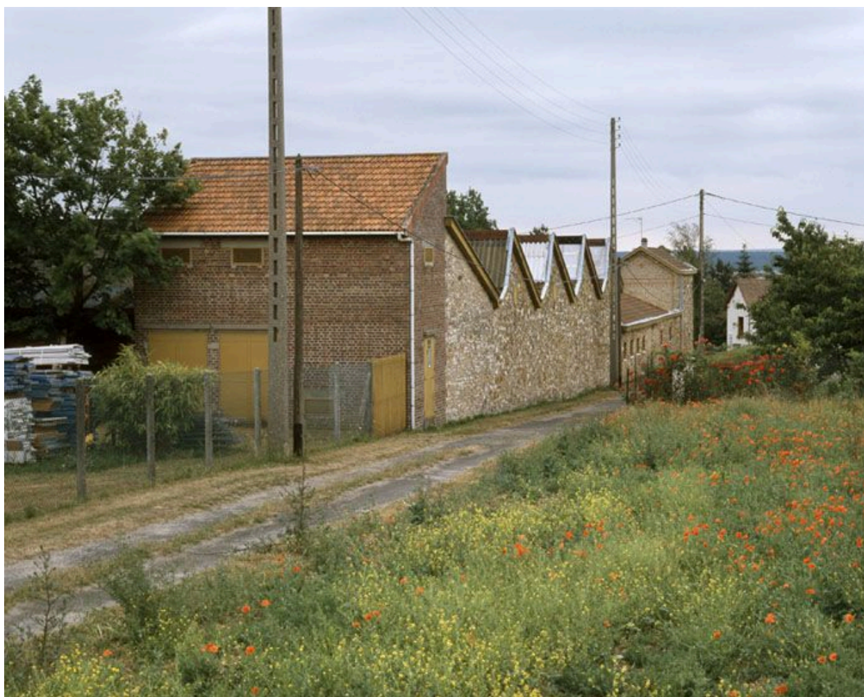
Façade arrière des ateliers.
