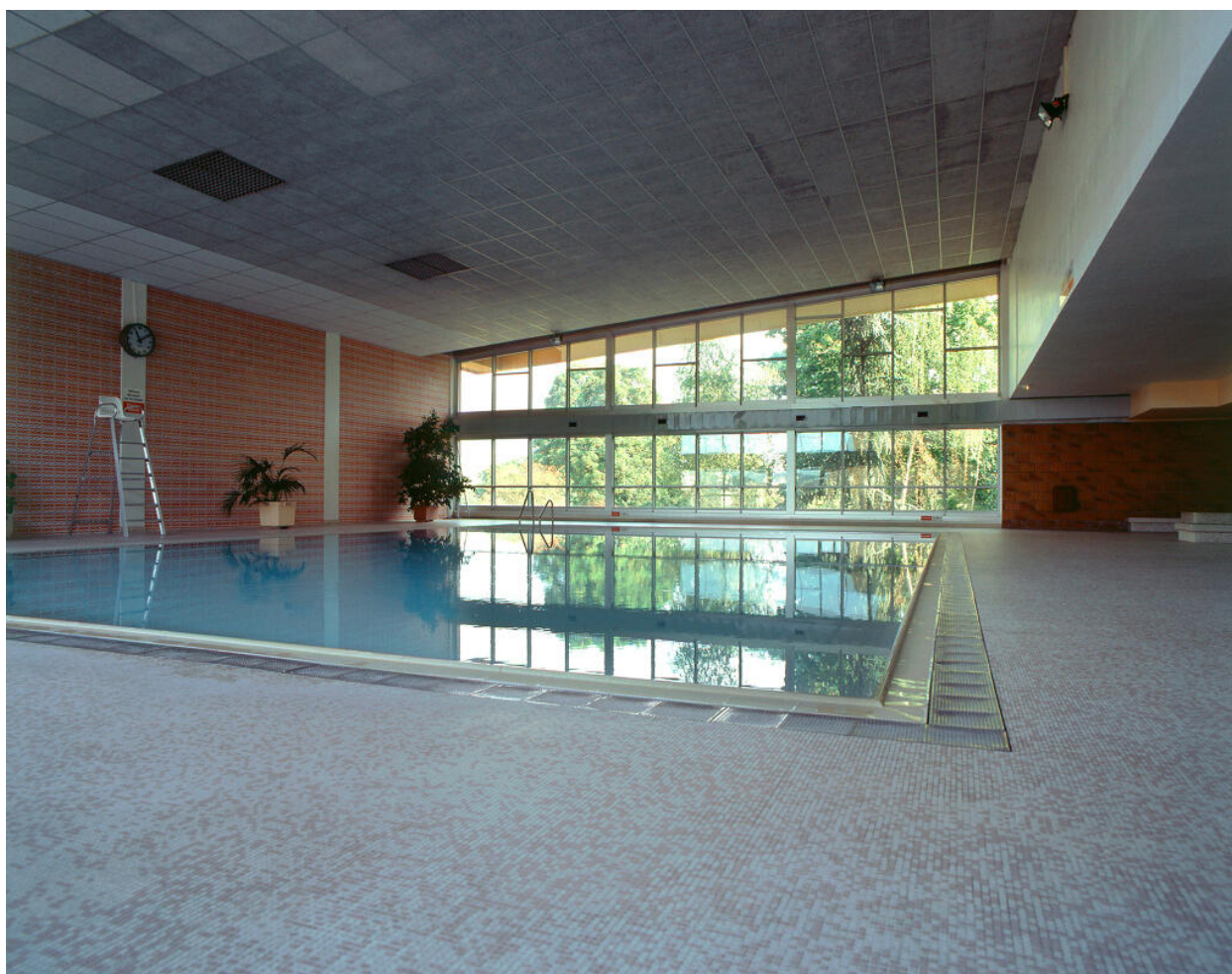
Vue d'ensemble du bassin d'apprentissage en 2003.
