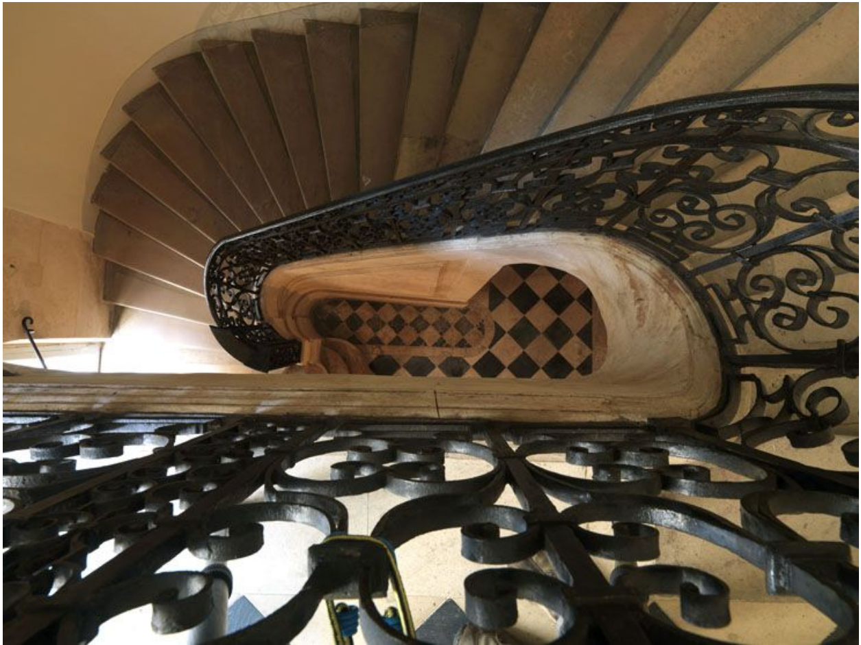
Vue en plongée du vide central.
