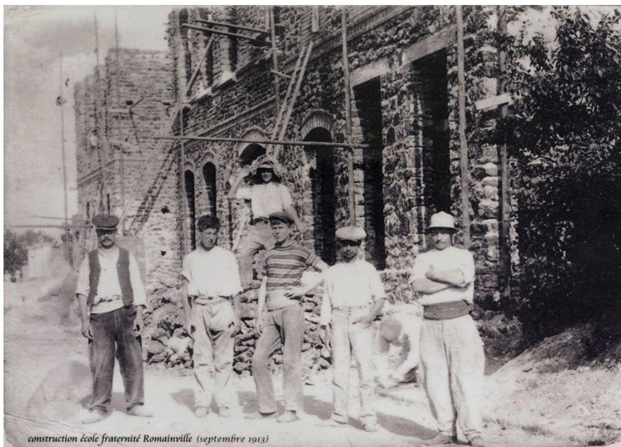
Carte postale ancienne figurant les chantiers des écoles. (AM Romainville)
