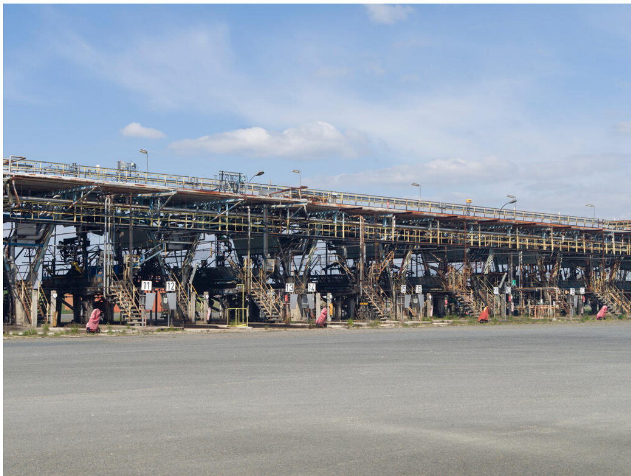
Quais de chargement route multiproduits (Unité 530).
