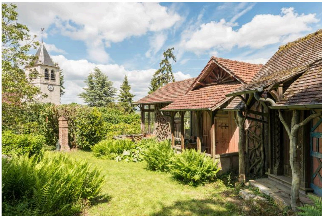
Vue générale des ateliers (6)
