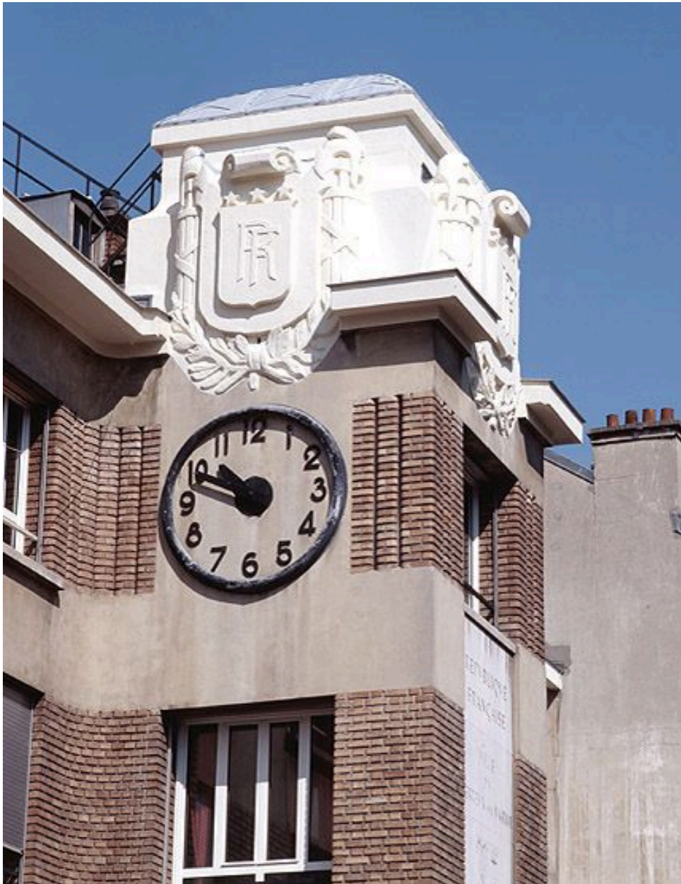
Détail du couronnement de la tour en façade.
