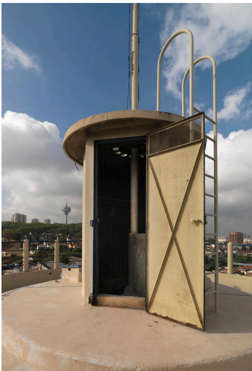
Site Biocitech. Vue du sommet du château d'eau.
