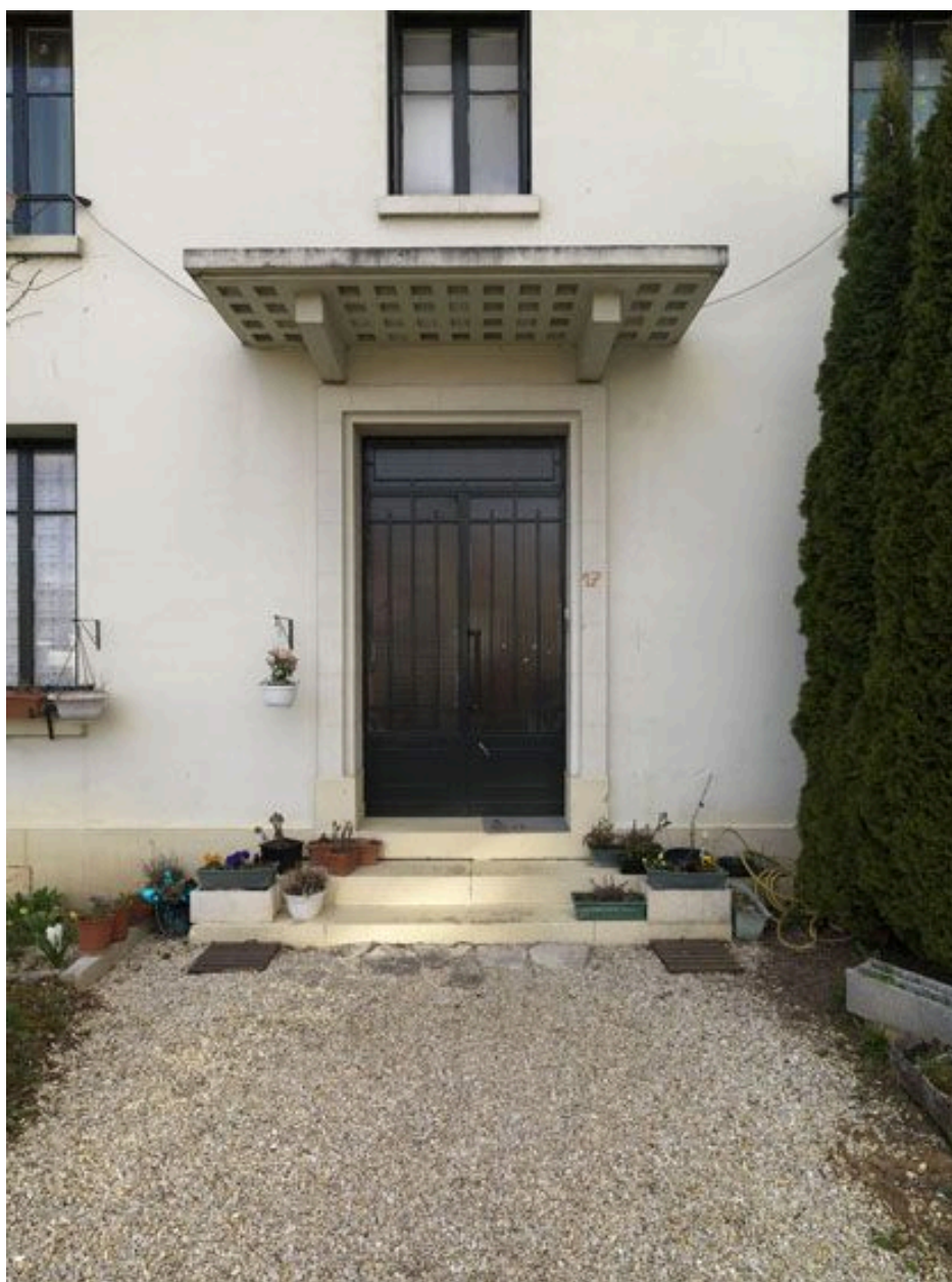
Logement de contremaître, détail de l'entrée.
