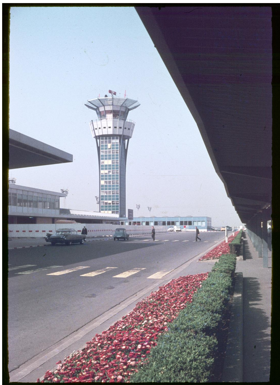
1964 1966, la construction de la tour de contrôle vue depuis le parvis des Installations Terminales.
