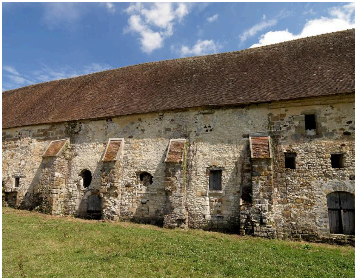
Détail façade ouest de la grange des Beauvais.
