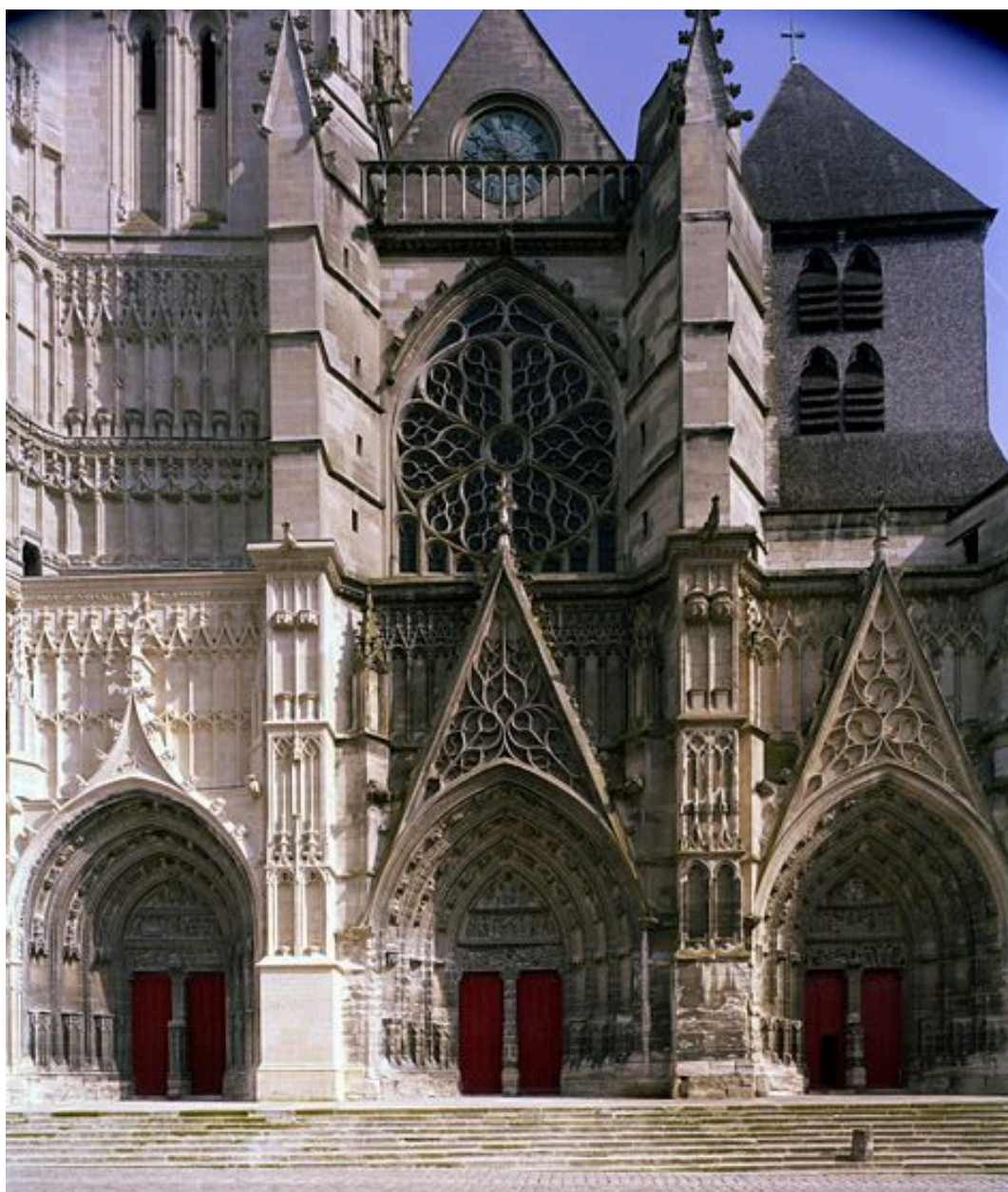
Les trois portails de la façade occidentale, et l'étage de la rose.
